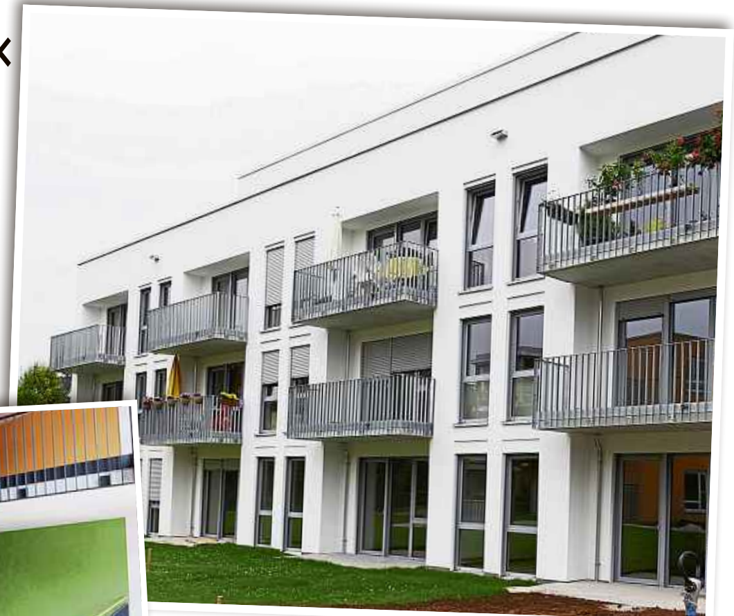
5,4 Millionen hat der Neubau der Wohnanlage gekostet.
